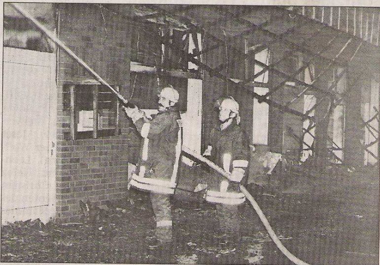
Während die Feuerwehrleute noch löschten, fiel nur wenige Meter weiter bereits die Dachstuhlverkleidung herunter
