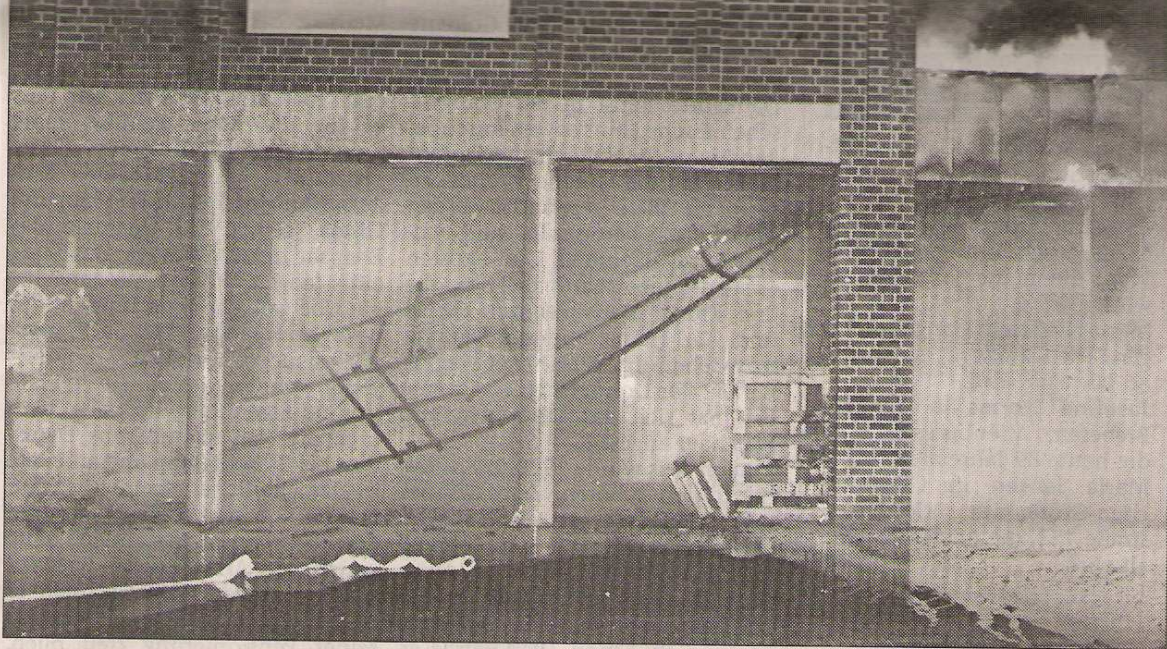
Ein Teil des neu errichteten Gebäudekomplexes in Übach-Palenberg wurde durch einen Brand zerstört. Das Einkaufszentrum „Am Wasserturm“ sollte nächste Woche eröffnet werden. Fotos: Georg Schmitz
