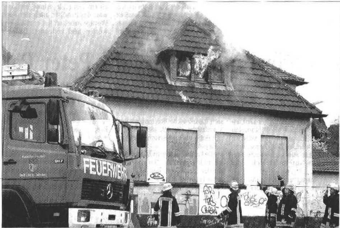
Feuer in Frelenberg: Zum zweiten Mal mussten die Feuerwehren zum ehemaligen Jugendheim an der Geilenkirchener Straße ausrücken. Diesmal brannte es im Dachstuhl. Foto: Georg Schmitz
